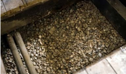
Bodemisolatie / kruipruimte isoleren
