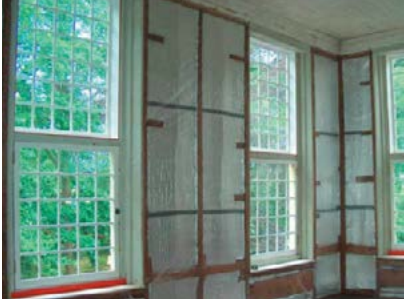
Dampdicht isoleren
