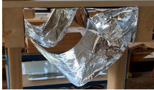
Vloer direct aan de onderzijde isoleren
